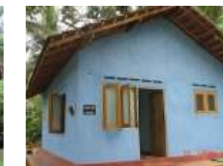
Renovierung und Ausbau (Februar 2008)
