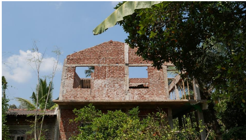
Haus Melan „ohne Dach“ Januar 2022
