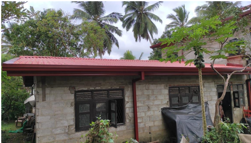
Haus Kavindi mit neuem Dach Februar 2022
