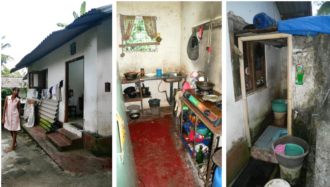
Haus Chathumi – Küche – Toilette & Außendusche
