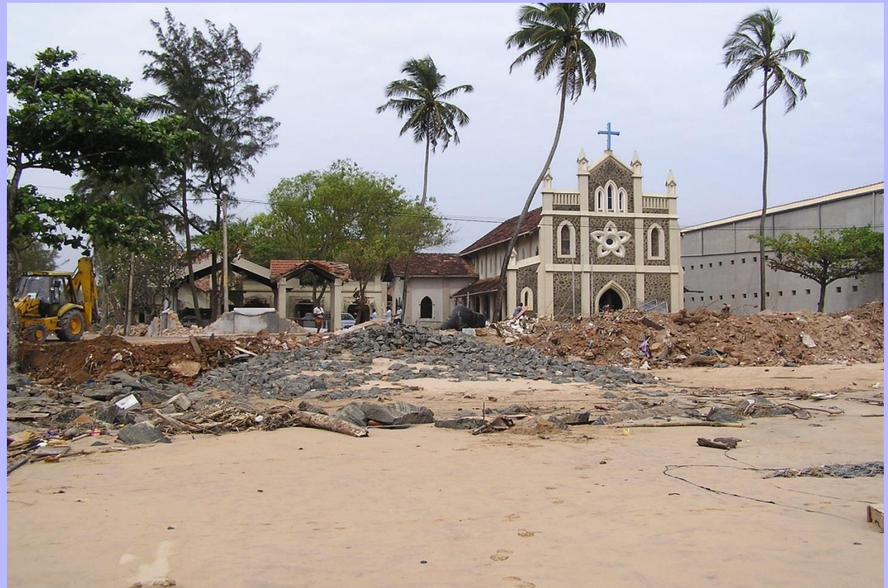
St. Mary's Convent nach der Flut (07.01.2005)
