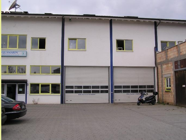
Lager Neufnach (ehem. Bauhof)
