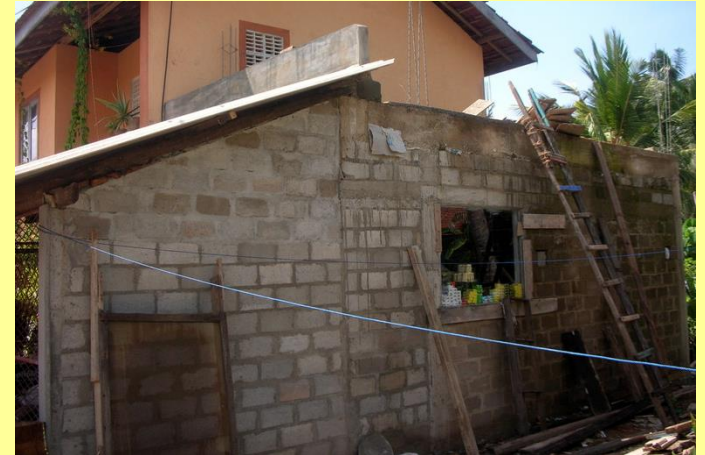
Geschäft im Ausbau (Mar 2008)
