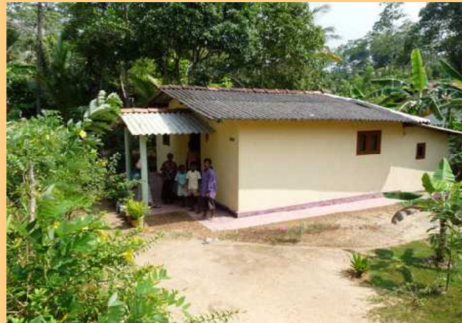
Haus Nalanda nach der Renovierung
