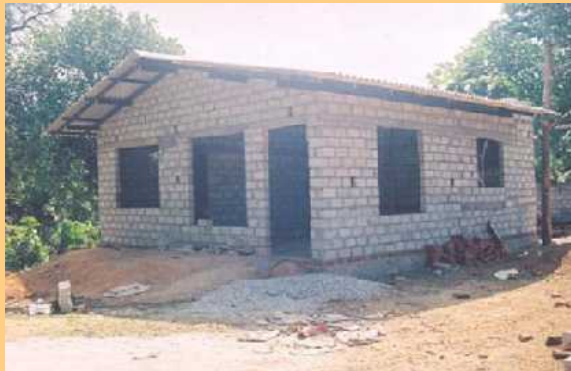
Rohbau Haus Perera
