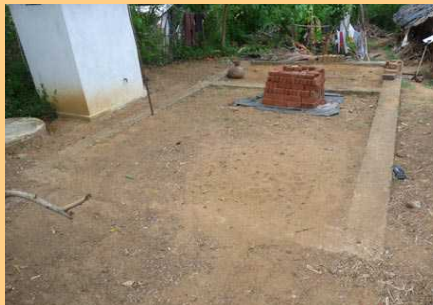
Fundament für Küche & Wohnraum
