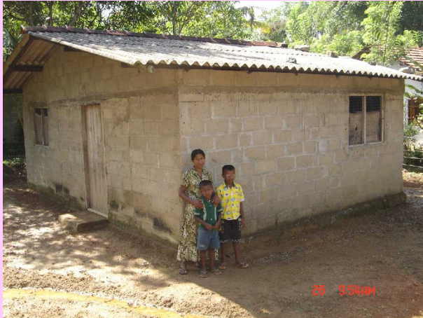
2008: Haus Nalanda vor der Renovierung
