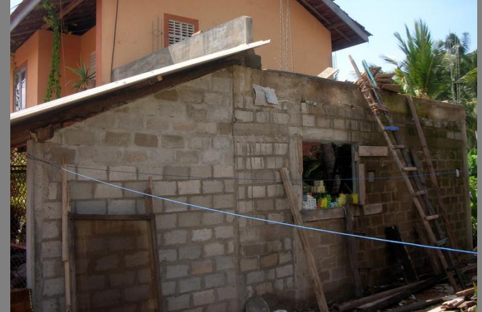
Geschäft im Ausbau (Mar 2008)
