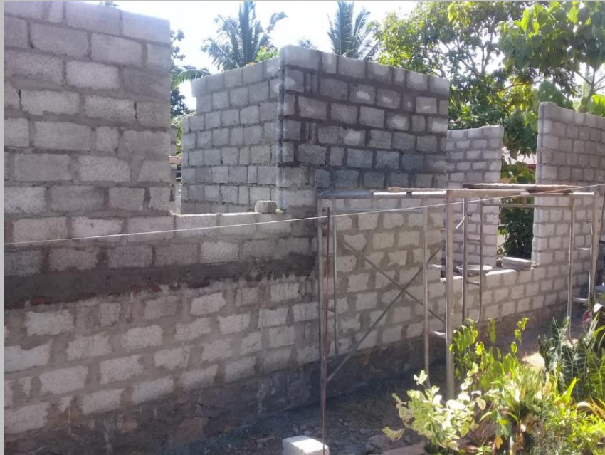
Rohbau Ende August 2020
