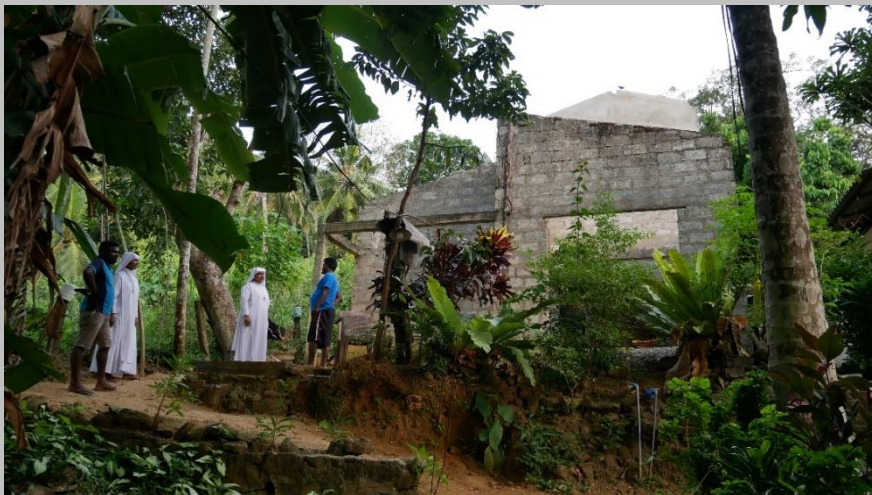
Haus ohne Dach, Januar 2020
