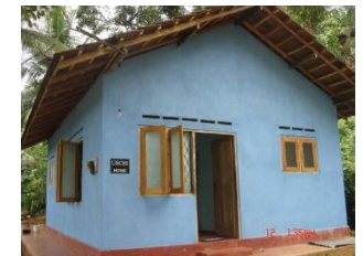
Renovierung und Ausbau (Februar 2008)
